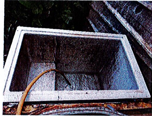
Photo 15 : Ancien congélateur utilisé pour accueillir l'eau du bassin de purge
